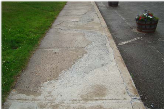
Spalling
