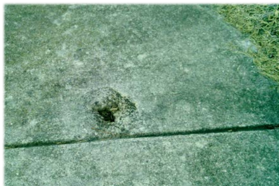
Spalling
